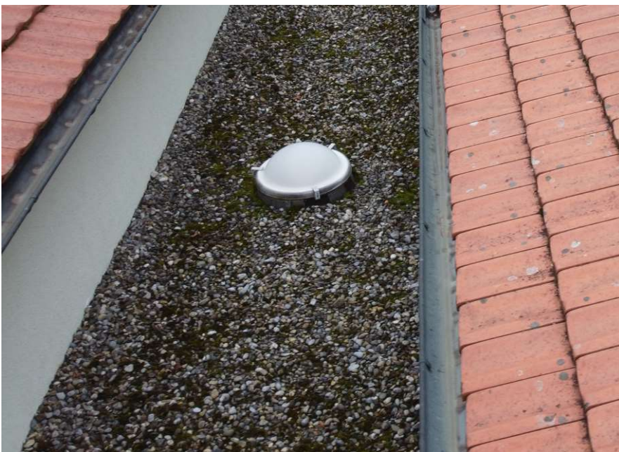
Foto: Flachdach Zwischenbau
